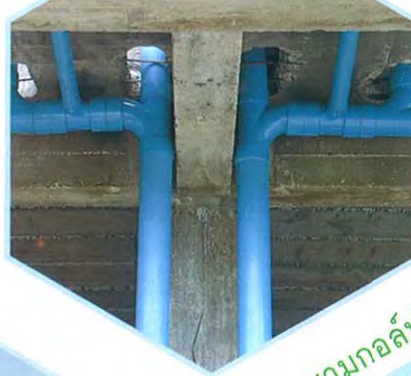
งานระบายน้ำ
